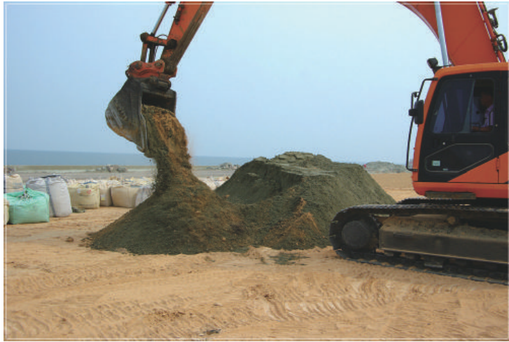
그림 4. 원토양과 토양개량재의 혼합작업(새만금방조제 2009)
