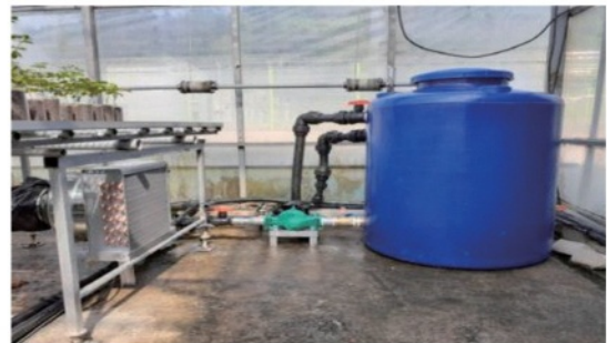
그림 3. 수냉식 팬코일 유닛 방식 냉방시스템 설계 도면 및 설치 사진
