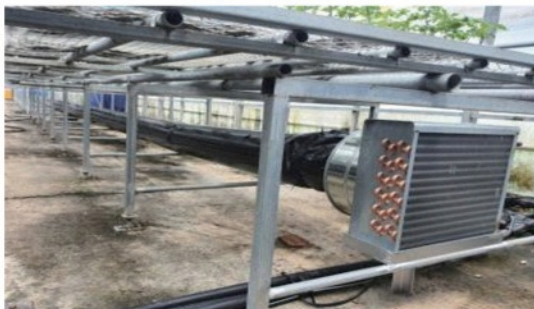
그림 3. 수냉식 팬코일 유닛 방식 냉방시스템 설계 도면 및 설치 사진
