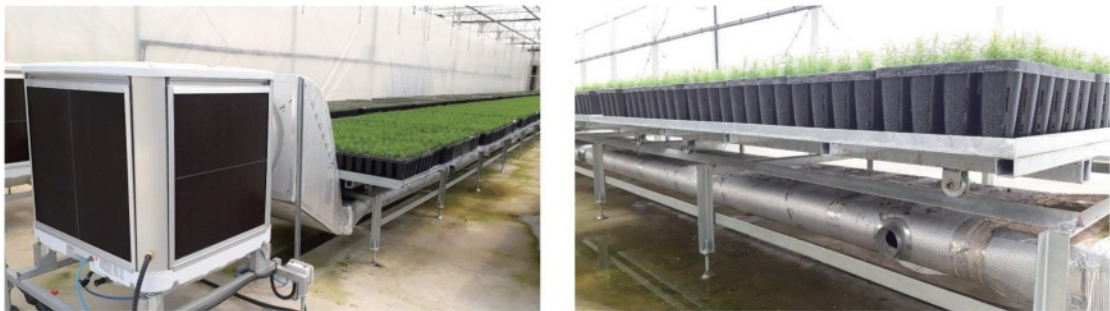
그림 2. 기화실 냉방시스템 및 송풍 덕트
