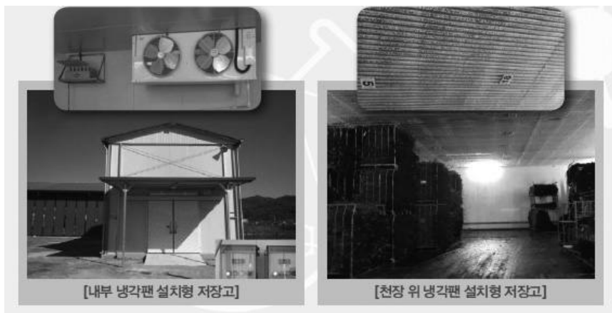
그림 3. 강제대류식(좌) 및 자연대류식(우) 저온 저장고
