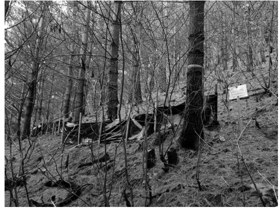
그림 2. 실트펜스 설치 모식도(좌) 및 현장에 설치된 모습(우)
