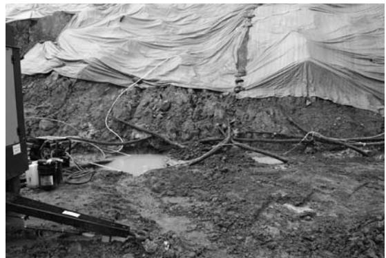
그림 4. 지하수 용출로 인한 땅밀림 산사태 발생지 사례
