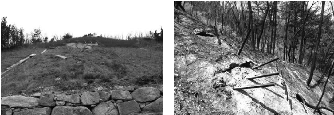
그림 9. 정밀안전진단을 실시하지 않고 복구공사를 실시한 후 땅밀림 산사태가 재발생한 사례
