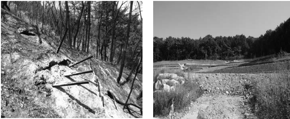
그림 8. 대표적인 이암지대인 포항지역에서 땅밀림 산사태에 의해 밀리는 억지말뚝이 암반에 직접 고정되지 못하는 경우와 땅밀림 산사태지에 시공한 가비온돌망태옹벽 처리 공법 적용 사례
