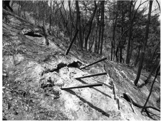
그림 5. 과거 사방녹화사업을 실시한 포항·영일지역에서 이암층이 풍화되어 집중호우시 상부토층을 밀고 내려오는 붕적층 땅밀림이 우려되는 사례
