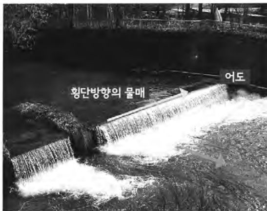
그림 3. 횡단방향으로 물매를 준 바닥막이와 거석으로 낙차를 완화한 사례(真駒内川)
