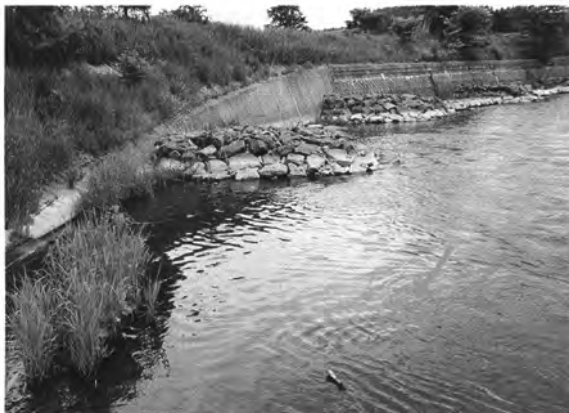
그림 19. 낮은 수제 + 밑막이를 설치한 사례의 근경과 원경(網走川)
