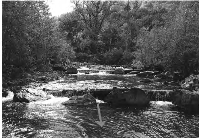
그림 20. 블록사방댐의 평면도와 시공 후 8년이 경과한 모습(판케오로피리카이가와)
