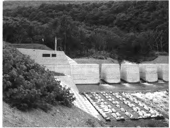
그림 4. 중간을 절단한 사방댐(丸平の澤)과 호로나이가와(幌内川)의 슬릿형 사방댐
