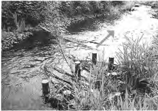
그림 16. 목공침상수제에 의해 월동장소를 복원한 사례(積丹川)
