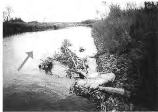
그림 17. 나무썰다발에 의해 월동장소를 복원한 사례(遠間川)
