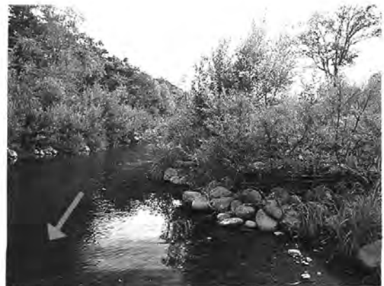
그림 12. 마코마나이가와(真駒内川)에 시공된 자연소재를 활용한 수제
