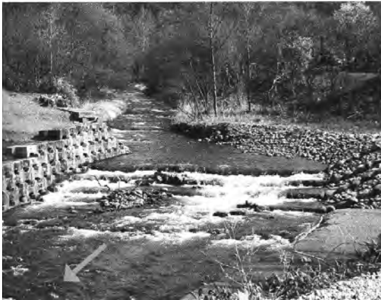
그림 2. 마코마나이가와(真駒内川)에 시공된 경사식 수로 및 전단면 어도
