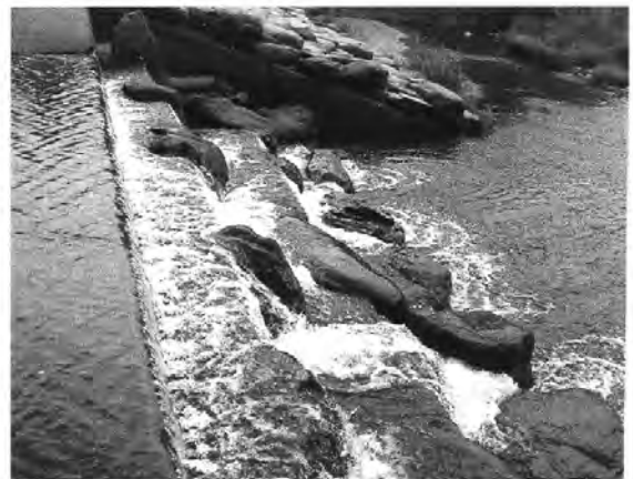
그림 3. 횡단방향으로 물매를 준 바닥막이와 거석으로 낙차를 완화한 사례(真駒内川)
