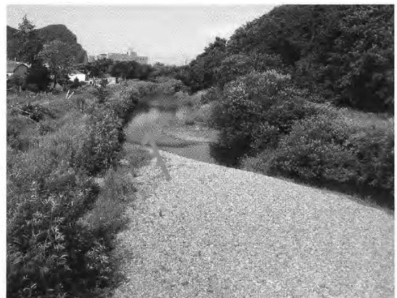
그림 13. 국소세굴로 기슭막이가 변형된 사례와 다량의 토사가 퇴적된 사례
