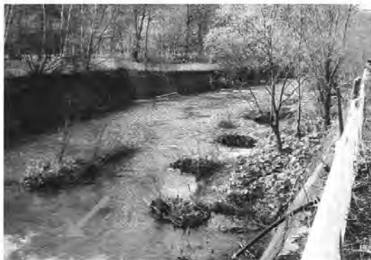
그림 15. 그늘 시설과 유도형 수제로 월동환경을 복원한 사례(眞駒内川)
