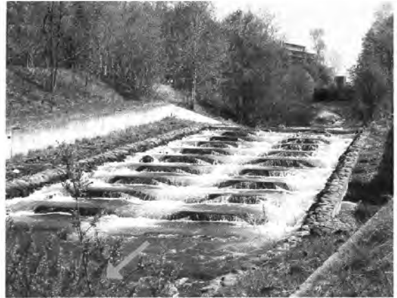
그림 2. 마코마나이가와(真駒内川)에 시공된 경사식 수로 및 전단면 어도
