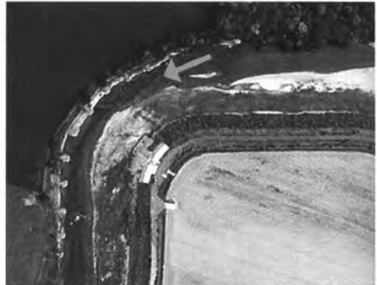
그림 19. 낮은 수제 + 밑막이를 설치한 사례의 근경과 원경(網走川)
