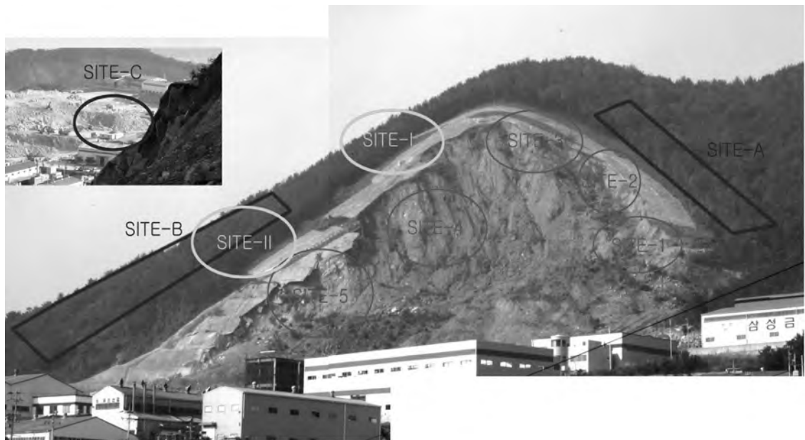
그림 1. 5차례에 걸쳐 재발된 경상남도 김해시 주촌면 내삼농공단지 땅밀림 산사태지 전경
