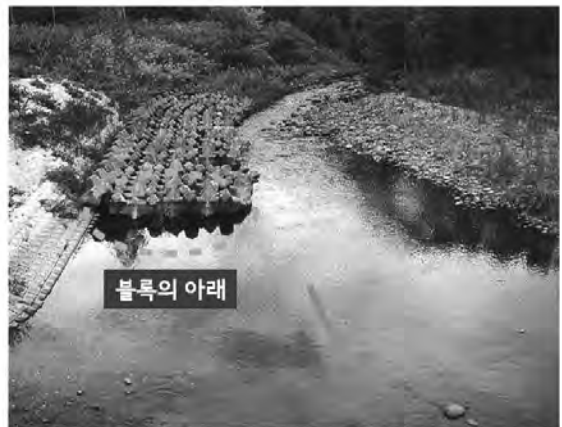
그림 5. 수제와 호안블록에 의해 형성된 월하장소(외쪽 網走川, 오른쪽 余布川)
