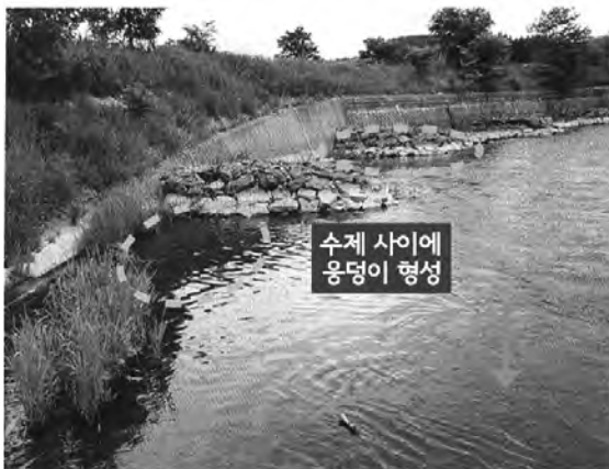
그림 5. 수제와 호안블록에 의해 형성된 월하장소(외쪽 網走川, 오른쪽 余布川)
