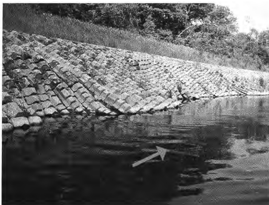
그림 13. 국소세굴로 기슭막이가 변형된 사례와 다량의 토사가 퇴적된 사례
