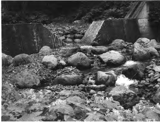
그림 4. 중간을 절단한 사방댐(丸平の澤)과 호로나이가와(幌内川)의 슬릿형 사방댐
