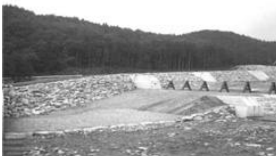
그림 6. 현지에서 발생한 전석을 이용한 유도둑(돌쌓기)
