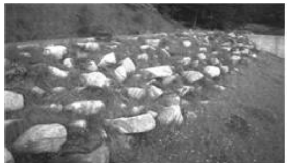
그림 6. 현지에서 발생한 전석을 이용한 유도둑(돌쌓기)
