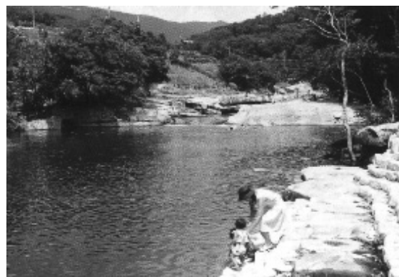
그림 8. 천연 화강암에 의한 고수부지(좌)와 계단식 기슭막이(우)
