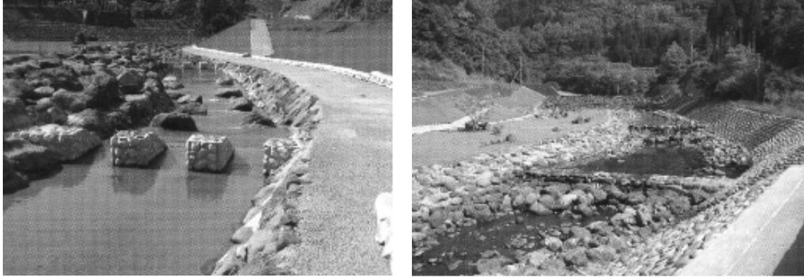
그림 11. 인공섬과 수로(좌) 및 자연석을 사용한 기슭막이(우)
