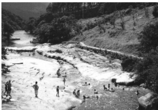
그림 8. 천연 화강암에 의한 고수부지(좌)와 계단식 기슭막이(우)
