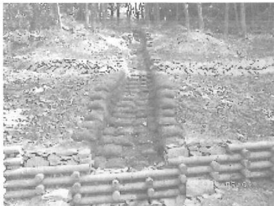
종자 부착 녹화 마대를 이용하여 수로를 조성한 전경
