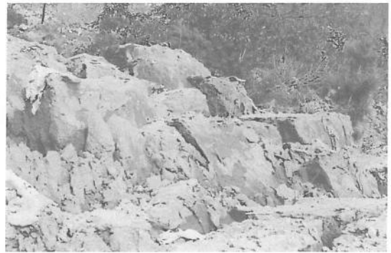
김해시 주촌면 내삼리 안산암질 응회암의 땅밀림 현상. 암석의 절리가 많으며 절리면을 따라 깊게 풍화되고 절리면은 점토질로 충전되어
