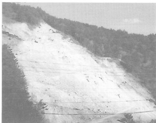
정선 북면 구절리 (오장폭포 옆) 산사태지 전경
