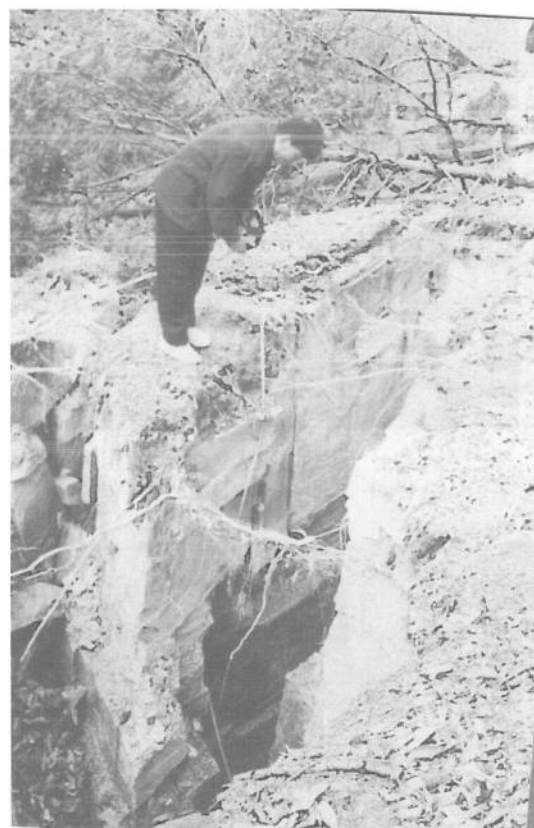
칠곡군 지천면 금호리 사암, 혈암의 절리를 따른 땅밀림현상
