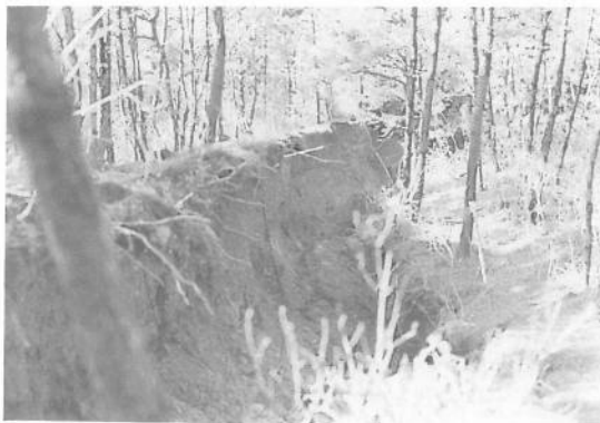
충남 당진군 송악면 부곡리 땅밀림지 전경. 퇴적기원의 준 편마암지대로 풍화가 깊게 진전되어 땅밀림이 발생되었다.
