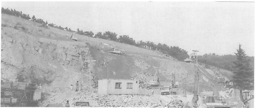
부산시 남구 대연동 산사태(땅밀림)지 전경. 혈암, 사암의 퇴적층으로 절리가 많으며 절리를 따른 심층풍화로 땅밀림이 발생되었다.
