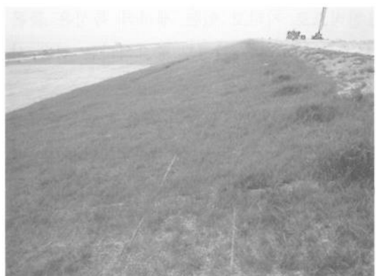
그림 4. 제체 사면에 15~30cm 산흙 복토를 하고 잔디로 녹화. 침식·비사방지, 경관보전 효과와 초본착생은 가능하나 수목의 생육은 어렵다.
