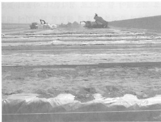
그림 5. 준설토 활용 수목생육기반 개발 처리구 조성중인 새만금 방조제 완경사면 현장
