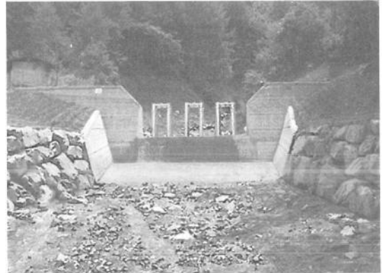
그림 6. 토석류, 유목 피해저지에 엄청난 위력을 보이고 있는 철강제 투과형(透過型)댐인 슬릿트댐. 스크린댐과 함께 빠른 속도로 보급이 확산되고 있다. 바닥 기초 콘크리트부가 수직이고 낙차가 큰 점은 개선해야 할 부분이다
