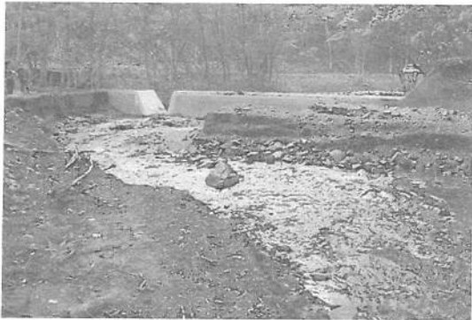
그림 7. 일본에서는 기존 사방댐의 방수로 부분을 잘라내 사방댐과 같은 횡공작물의 상하류간 생태계 단절이라는 비판에 대응하고 있다.
