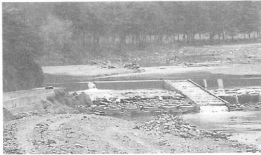
그림 10. 어류가 물을 타고 오를 수 있는 구조로 되어있지 않아 기능을 제대로 못한다는 지적이 있다.
