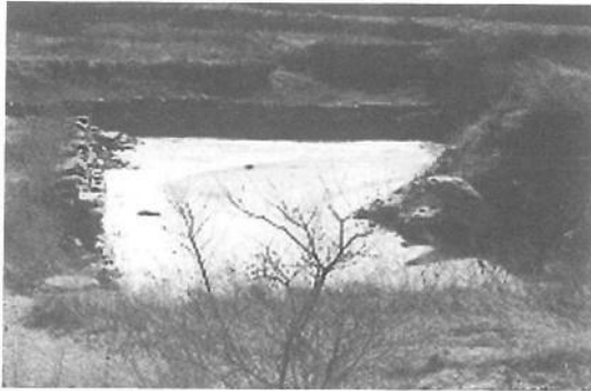
저수용 탱크(문두구기존 저수지)
