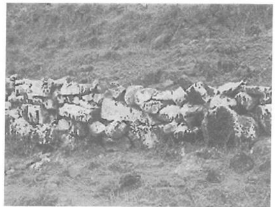
C type 정지방식(사진 좌측은 산돌쌓기 뒷면, 우측은 전면)
