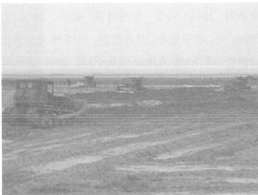
Tractor에 의한 정지작업 광경
