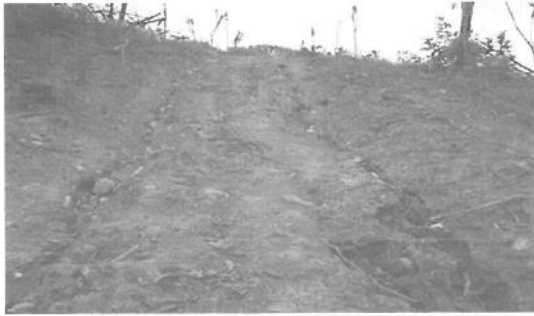
그림 10. 보강지 유역내 작업로. 기계압으로 다져진 상태이며 규모가 너무 커서 침식·붕괴 위험이 높다.
