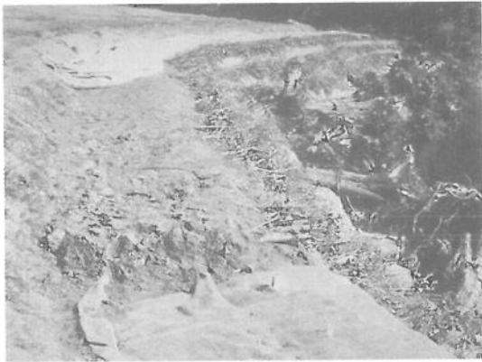
그림 10. 부분적인 식생-지오그리드 공법 적용
